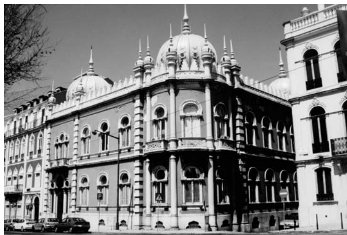
Figura 6 – Mosteiro dos Jerónimos e Palácio Ribeiro da Cunha (Reitoria da Universidade Nova de Lisboa, até início de 2002) - exemplos de aplicação dos calcários cretácicos da região de Lisboa em edifícios da cidade.
